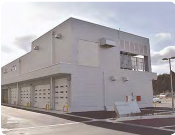
併設された車庫棟
