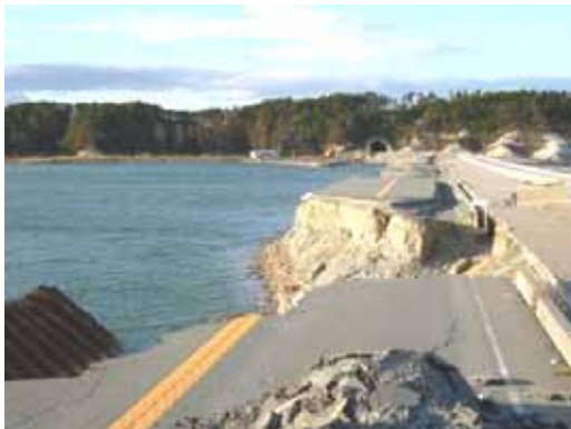
写真3 津波で寸断された道路（松川浦大洲海岸） (10月3日撮影)
