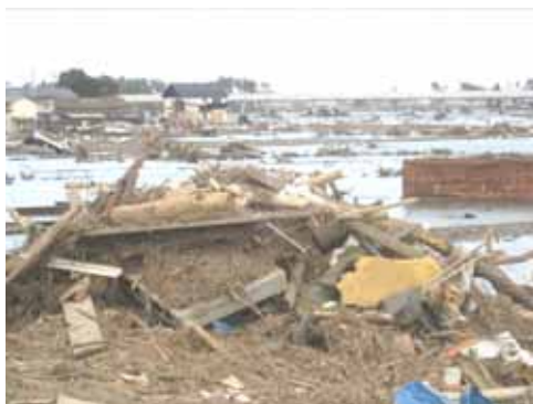
写真1 仙台空港近辺の状況（後方に仙台空港鉄道高架橋）（3月24日撮影）
