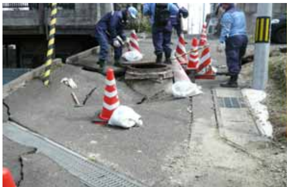
写真3 マンホール周辺における被災の例
