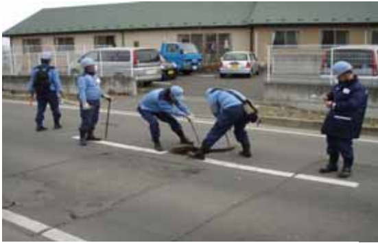
写真1 管路調査はチームプレーで
