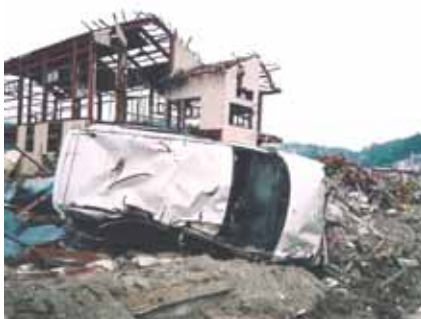
写真1 横転した自動車 (南三陸町役場付近)
