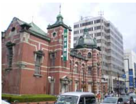
写真2 岩手銀行旧本館(手前)と106ビル(奥)(4月20日撮影)
