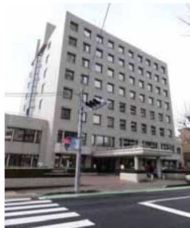
写真1 県災害対策本部が置かれた 福島県自治会館
