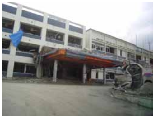
写真1 被災した陸前高田市役所
