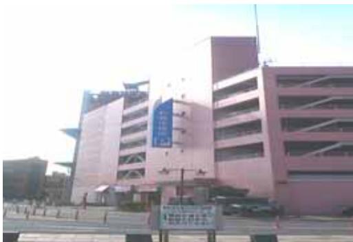
写真1 石巻市役所の概観(市役所周辺は被害が比較的軽微であった。) (6月初旬)
