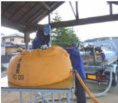
写真2 「バルーン」と呼ばれる応急給水器に給水している様子
