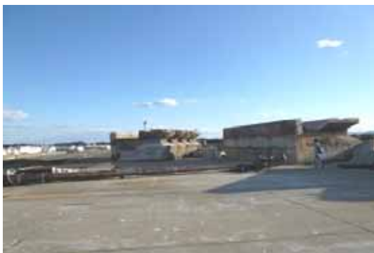
写真4 津波で打ち上げられた岸壁（相馬港二号埠頭） (10月3日撮影)
