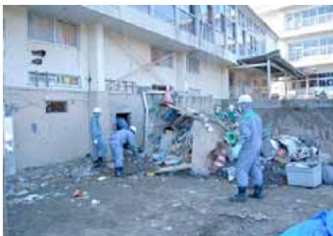
写真5 都職員による学校清掃 (4月14日撮影)
