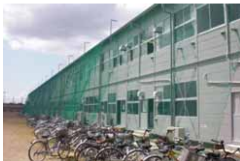
写真1 北高の敷地内にある仮設校舎
