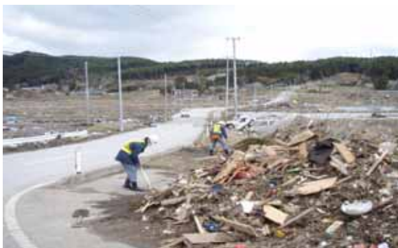
写真1 がれきの撤去作業（4月20日撮影）
