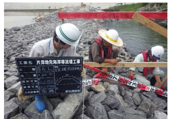
片岸海岸導流堤現場立会状況
