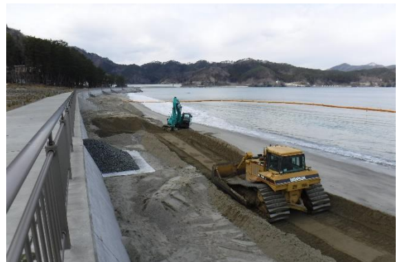
根浜海岸の砂浜再生工事状況
