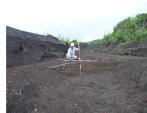
平成26年度豪雨被災状況
