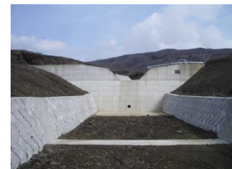
施工イメージ
