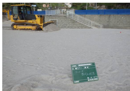
平成26年度神津島港海岸養浜工事 敷均し状況
