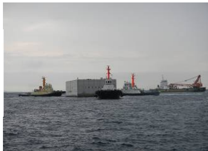
ケーソンを運搬している様子
