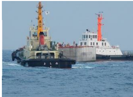
ケーソンを運搬している様子
