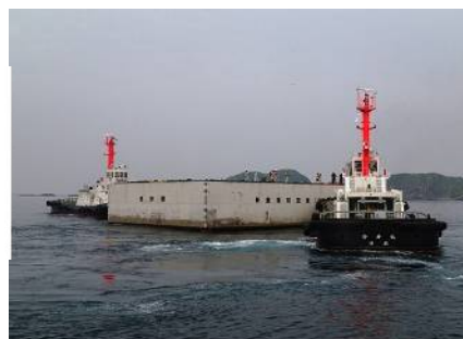
ケーソンを運搬している様子
