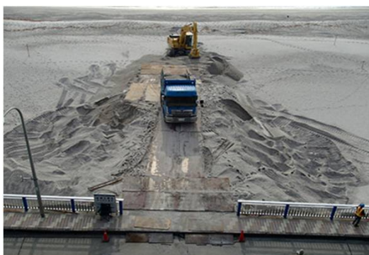
平成26年度神津島港海岸養浜工事 土砂搬入状況
