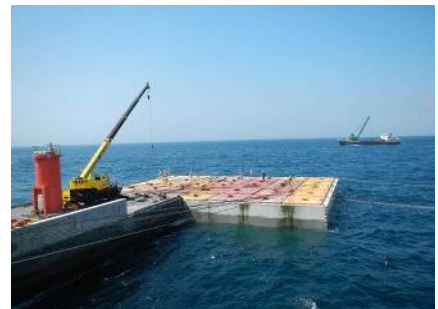
ケーソンを沈めた様子（防波堤（北））
