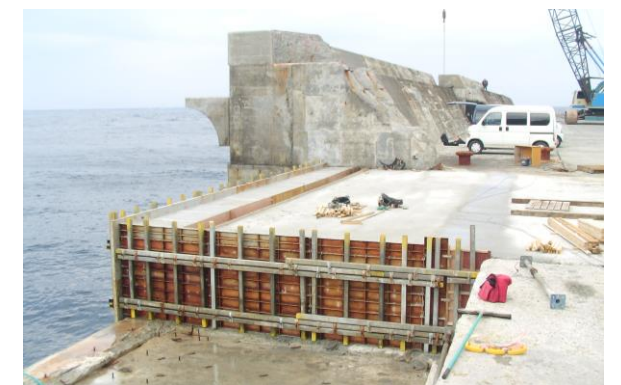
上部コンクリートの復旧状況 平成31年2月26日撮影
