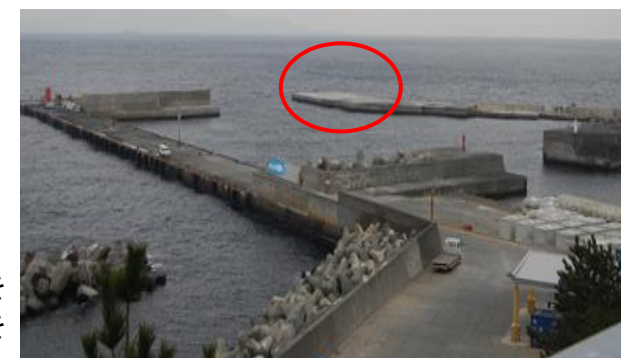
ケーソン据付完了
