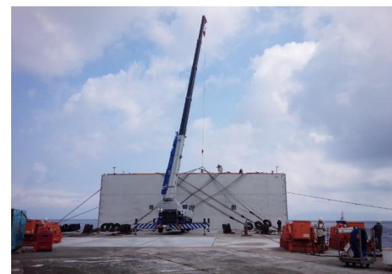
ケーソン据付状況
