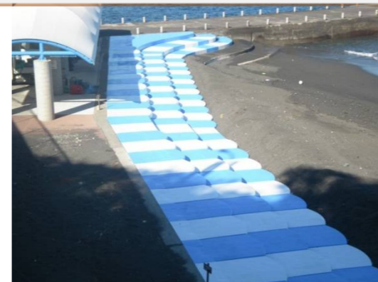
階段部塗装完了
