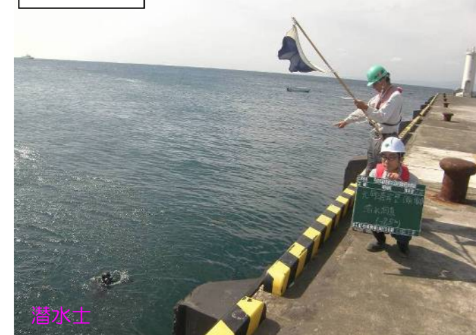
潜水調査状況
