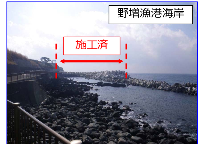
整備の進む離岸堤
