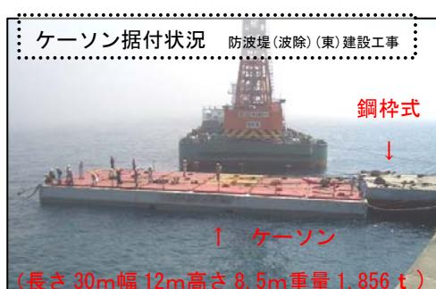
ジェットホイル高速船や漁船等が安全に接岸できるように、東側に新たな防波堤（波除）の建設に今年度より着手し、今年の 7/27 にケーソン 1 枚の据付けも無事完了しました。
