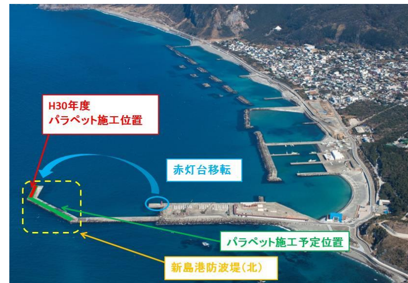
防波堤（北）の整備状況
