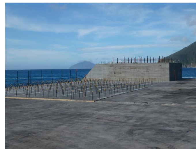
パラペット施工状況
