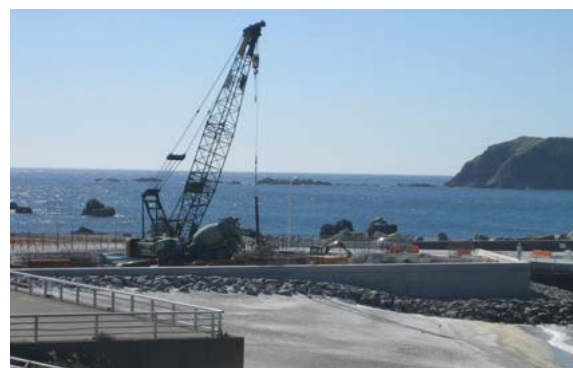
現在工事中の緑地施設休憩所
