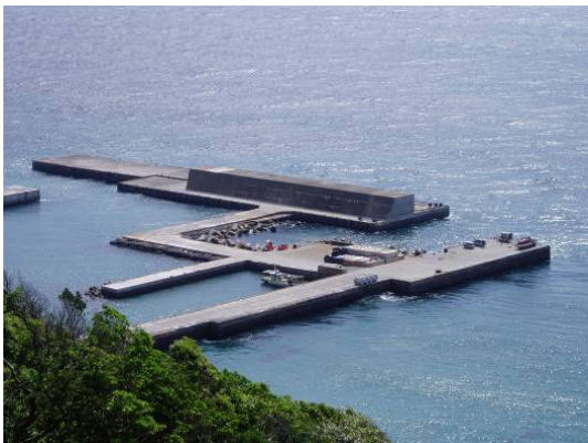
ケーソン据付前
