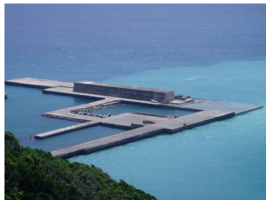
ケーソン据付後
