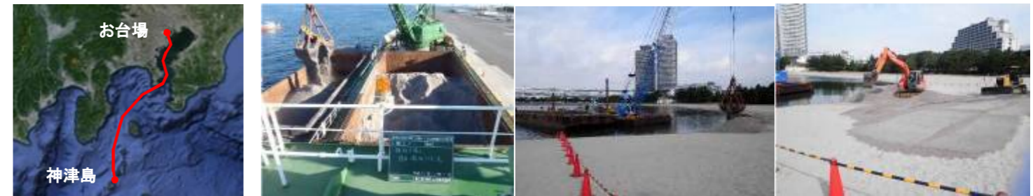
海上運搬 → 積替え → 砂浜へ投入 → 敷均し
