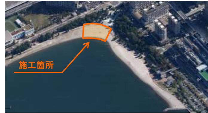
お台場海浜公園ビーチ 本年度養浜施工箇所
