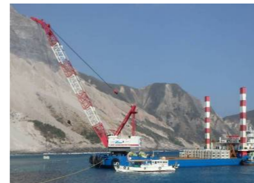
据付状況（海上）
