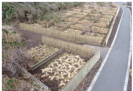
▲三根地区の垂戸保安林改良緊急工事
