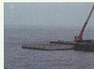
無事、据付完了
