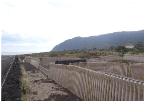
三根地区の中浦保安林改良緊急工事
