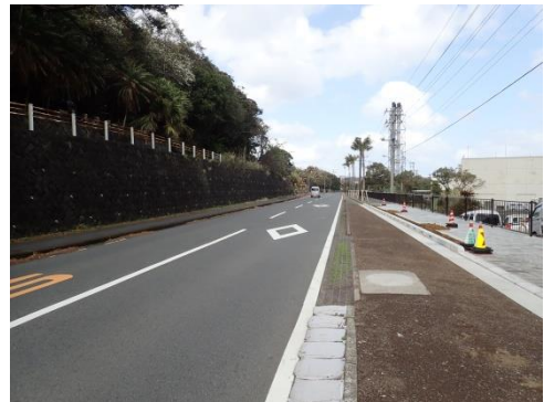
火力発電所前の道路拡幅工事
