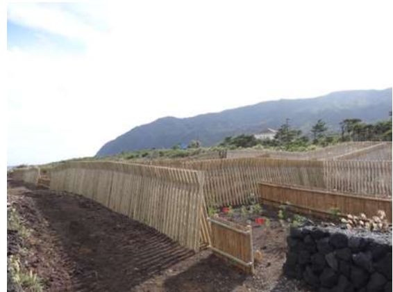
三根地区の保安林改良工事
