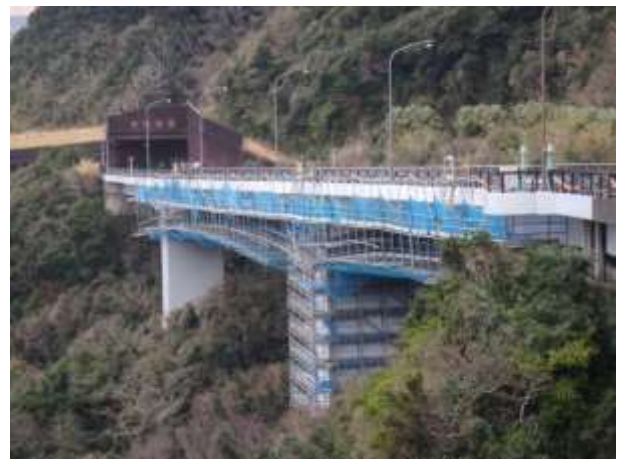
逢坂橋の補修工事
