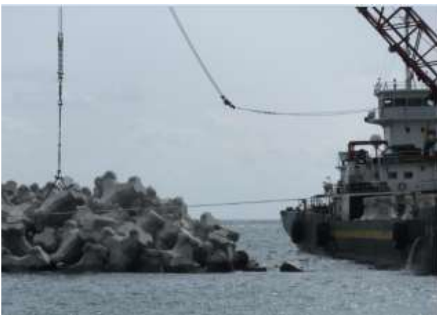
洞輪沢漁港消波ブロック据付
