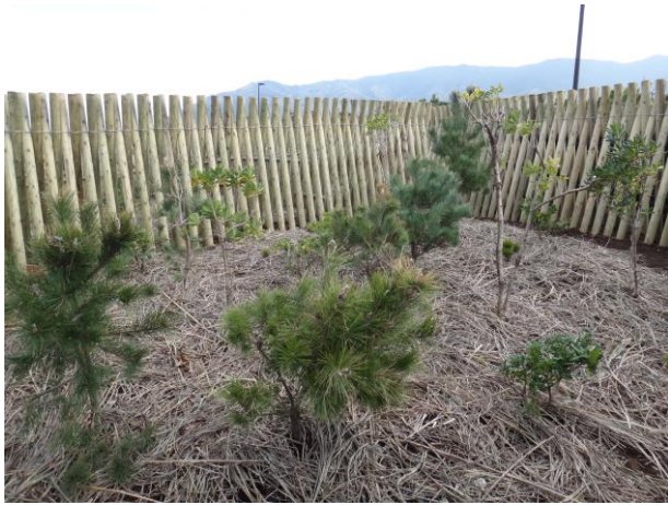
三根地区の保安林改良工事
