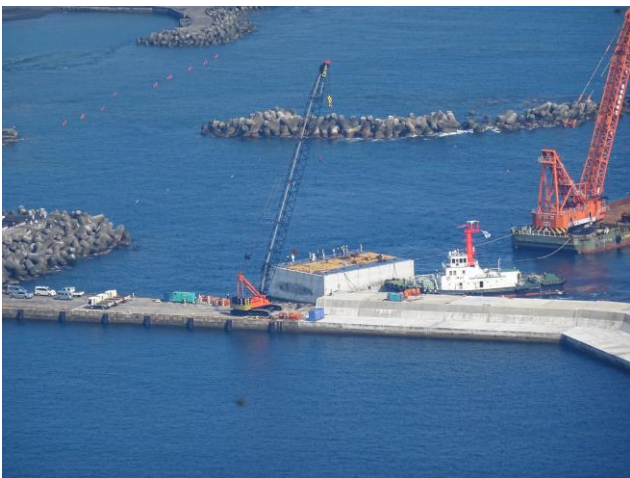
神湊港ケーソン据付
