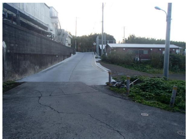
発電所付近の道路改修
