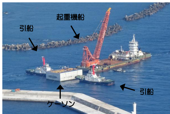
現場の様子(ケーソンを起重機船と引船で動かしている)
