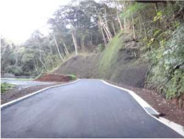
こん沢林道都単改良工事
