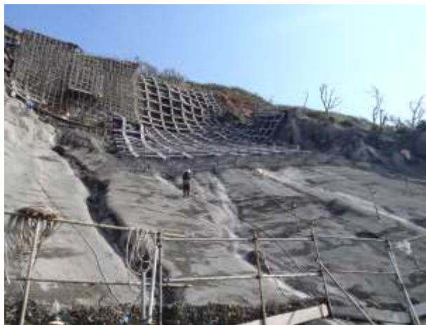
青ヶ島における法面補強工事
