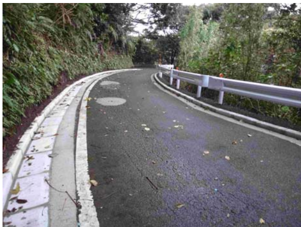
三原林道改良工事
