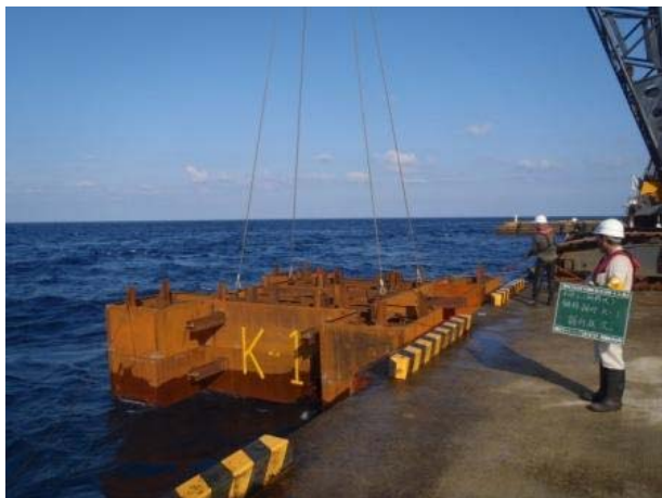
青ヶ島(三宝)港における鋼構据付状況
