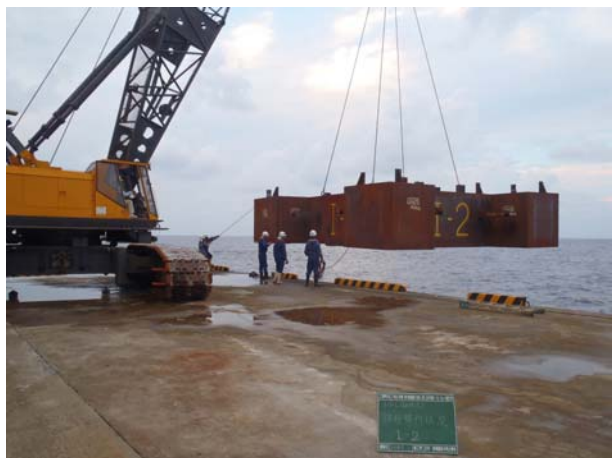
青ヶ島港(三宝港)護岸整備工事
