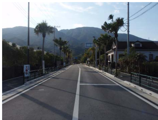
東畑交差点付近の歩道設置工事
