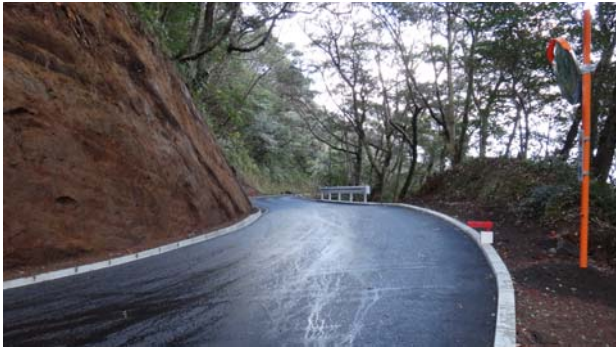
三原林道の改良工事
