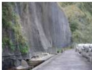
都道217号線「汐間道路」の切立った斜面
