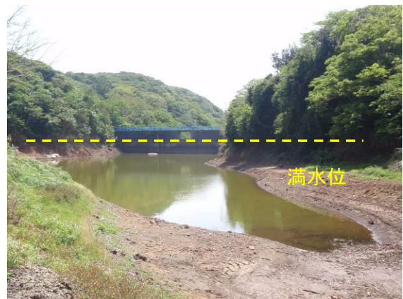
写真1 玉川ダム貯水状況（4/23）
