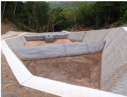
写真 沈砂池(平成21年3月完成)
