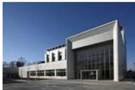
<多摩テクノプラザ本館>
