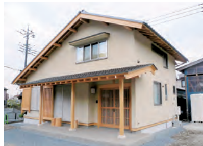
多摩産材を使用しているモデルハウス (「環の家」(日の出町))
