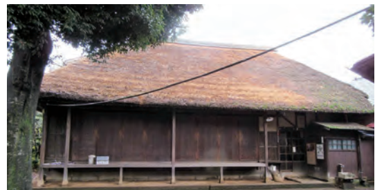
修復された文化財 (武蔵野(野川流域)の水車経営農家(三鷹市))
