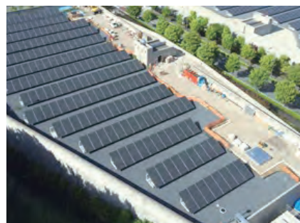
鑓水小山給水所の太陽光発電設備
