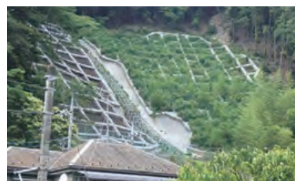
法枠工 高尾地区
