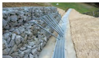
集水工 寺岡地区
