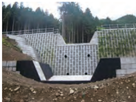
砂防堰堤工 海沢川
