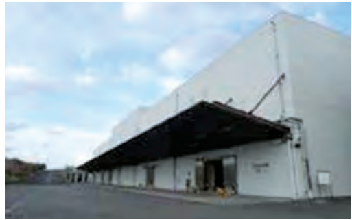
東京都多摩広域防災倉庫
