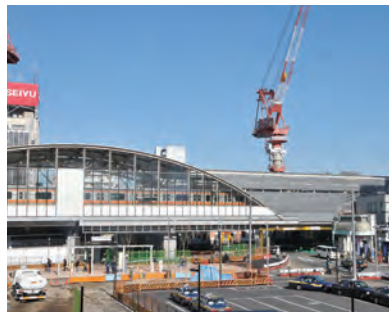
JR 中央線三鷹～国分寺間高架工事 （武蔵小金井駅）
