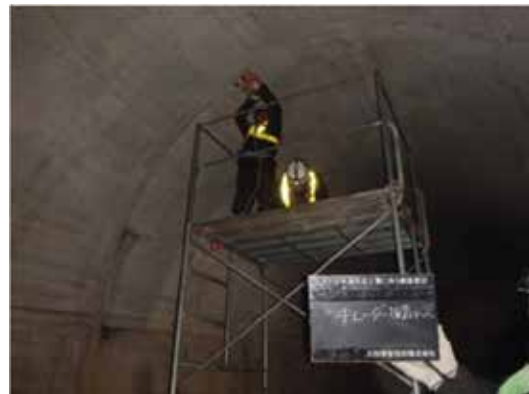
電磁波レーダ探査による調査状況
