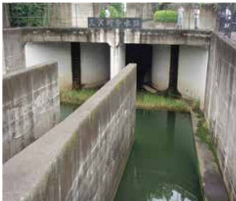
三沢川分水路
