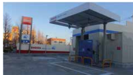
八王子高倉水素ステーション (出典: JX エネルギー株式会社)
