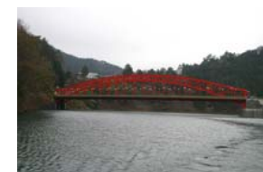
橋梁の長寿命化
