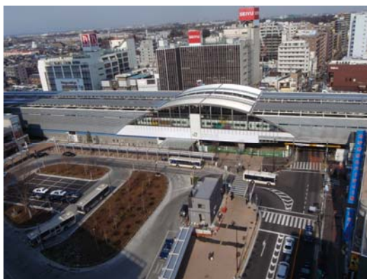
連続立体交差化事業 (JR中央線 武蔵小金井駅)
