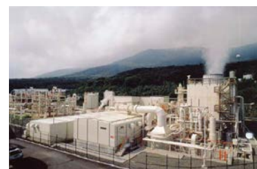
八丈島地熱発電所
