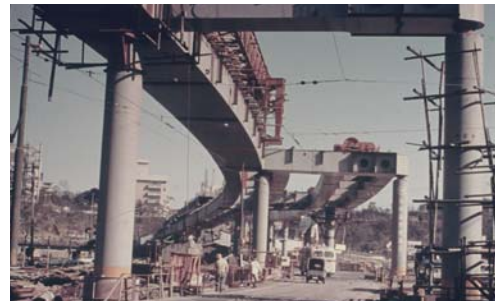
首都高速4号線の建設（赤坂見附） （特集「近づく東京オリンピック」昭和38年11月）
