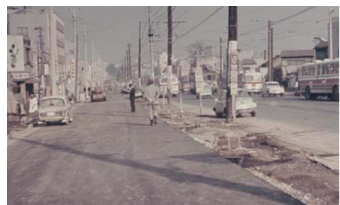
道路の拡幅工事（世田谷区池尻） (特集「近づく東京オリンピック」昭和38年11月)
