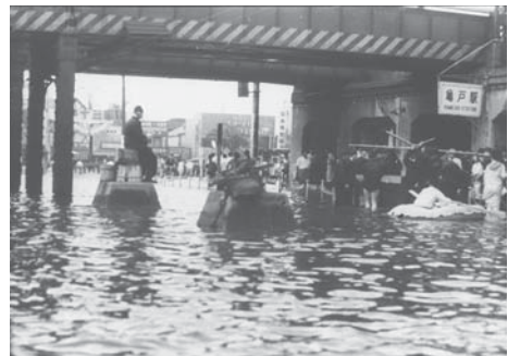
水害の様子：亀戸駅 （第97輯「東京の低地と川」昭和35年7月）
