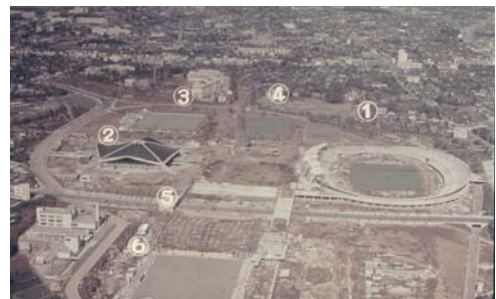
駒沢オリンピック公園総合運動場の建設 (特集「近づく東京オリンピック」昭和38年11月)
