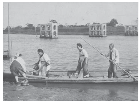
中川の渡し （第17輯「東京の道路」昭和28年10月） *後方に見える四角いコンクリートは、建設中の飯塚橋橋脚
