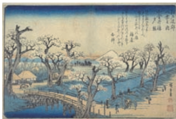
補植前の小金井橋付近の桜並木を描いたもので、枯木化している様子も見る事ができる。
