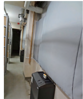
画像 17 窓に設置した遮光カーテン 外風で膨らんでいる様子
